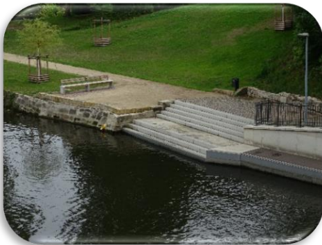
Abbildung 3 - Messstelle Fluss (-----wehr)
